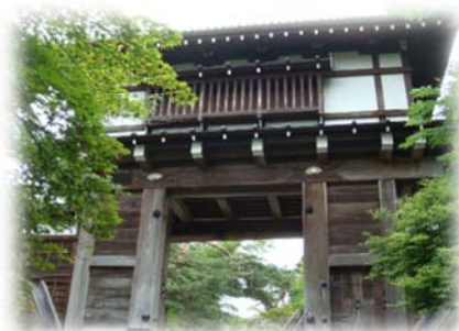
平成12年に復元整備された表門
