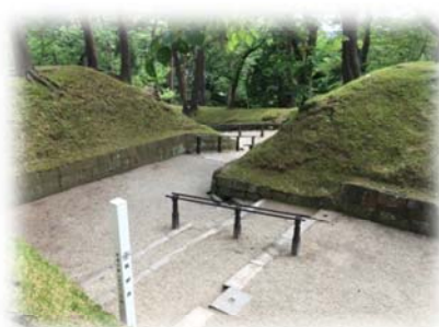
長坂の坂道改善策（手すりの設置）
