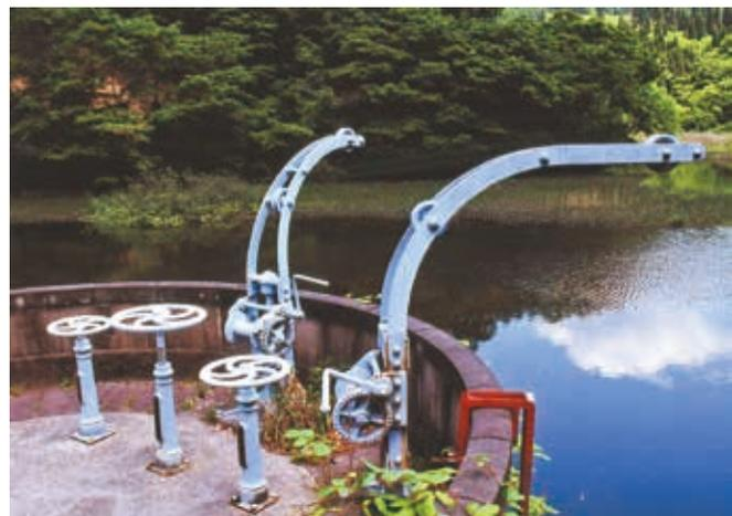
堰堤の上部。半円形状のバルブ塔が突き出ている
