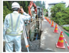
下水道管路工事
