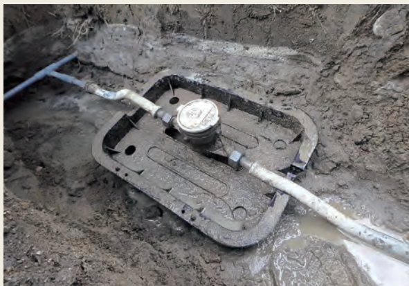
鉛製給水管の使用状況
