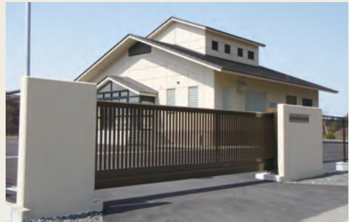
河辺岩見農業集落排水処理施設
