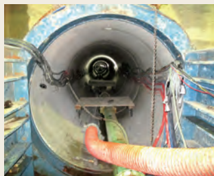
雨水幹線工事(左)と工事に使用する推進機(右)
