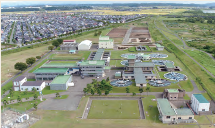
仁井田浄水場
