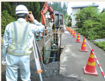
下水道管路工事
