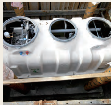
市設置浄化槽工事
