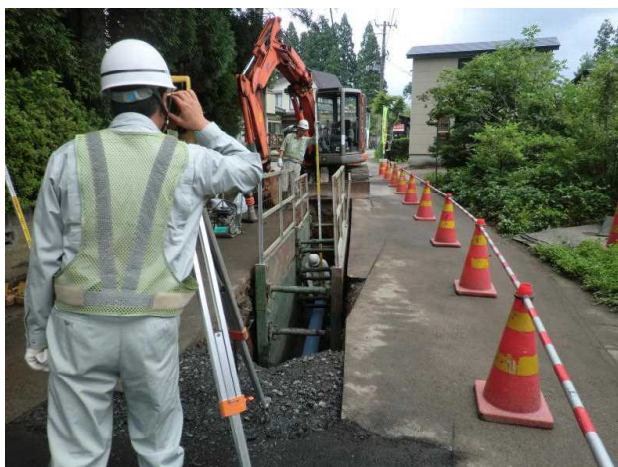
下水道管路工事
