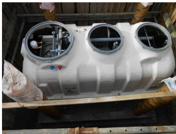
市設置浄化槽工事
