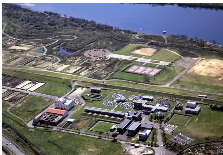
仁井田浄水場
