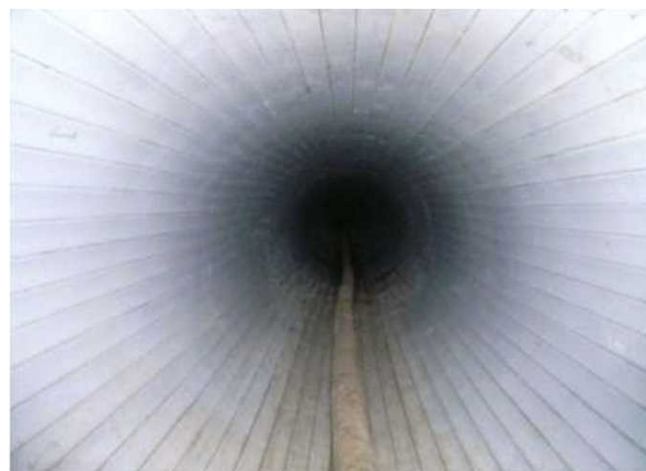
更生後の下水管内面
