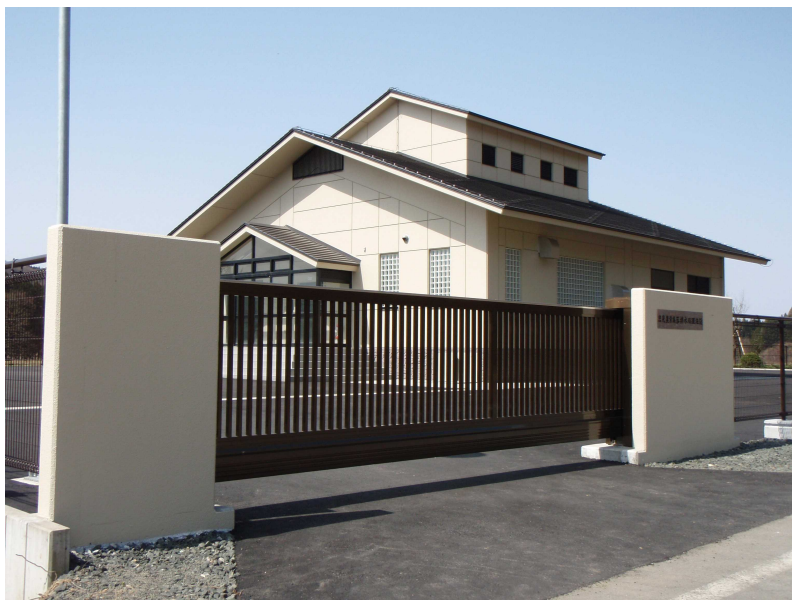
河辺岩見農業集落排水処理施設
