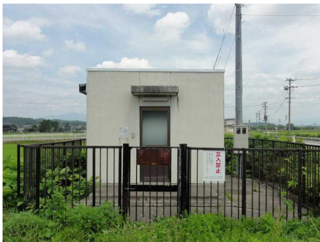
戸島送水ポンプ場
