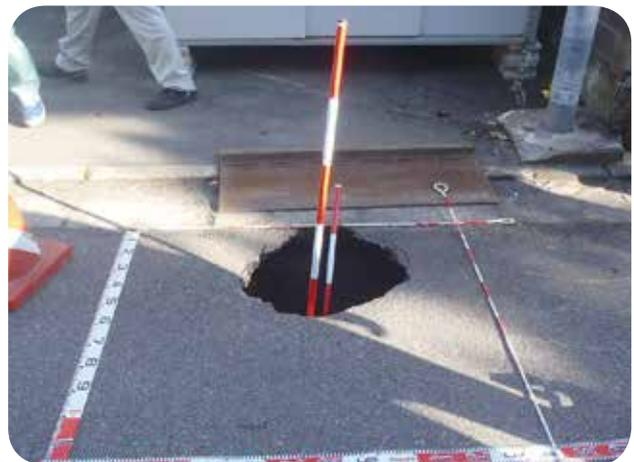
老朽化した下水管による道路陥没
