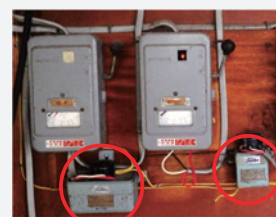
配電盤内の低圧進相コンデンサー
