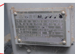
配電盤内の低圧進相コンデンサー
