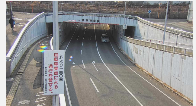
明田地下道（東通側）
