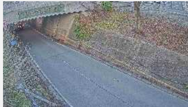
天徳寺地下道
