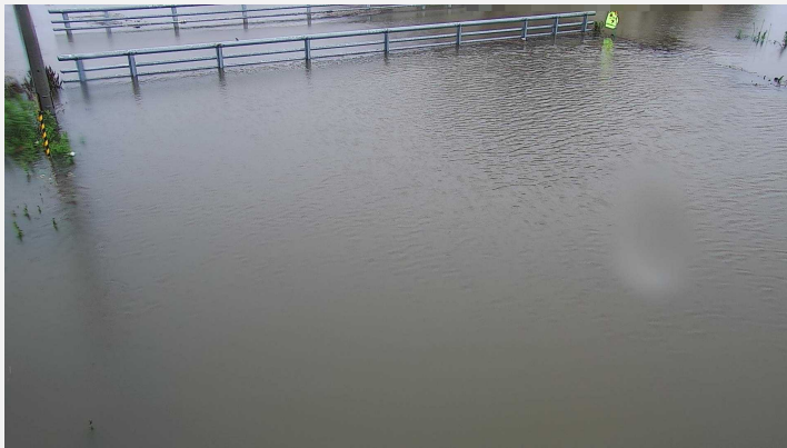
西潟敷一号橋
