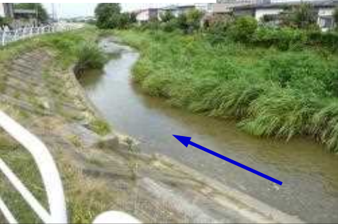
猿田川橋下流部(起点部)
