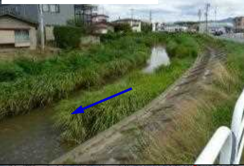
猿田川橋下流部(起点部)
