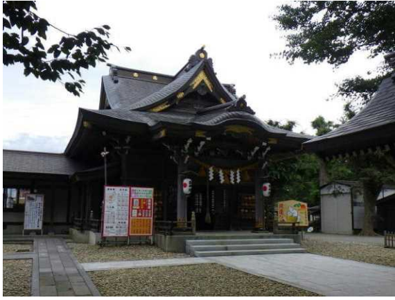
[写真1] 本宮外観
