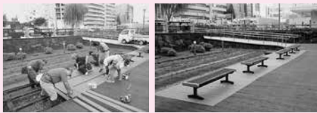
作業の様子。右が完成後のウッドデッキ
