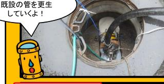
管きょを更生する際、 多くの施工箇所で 地震に強い継手を 使用して地震対策を 行っています!
