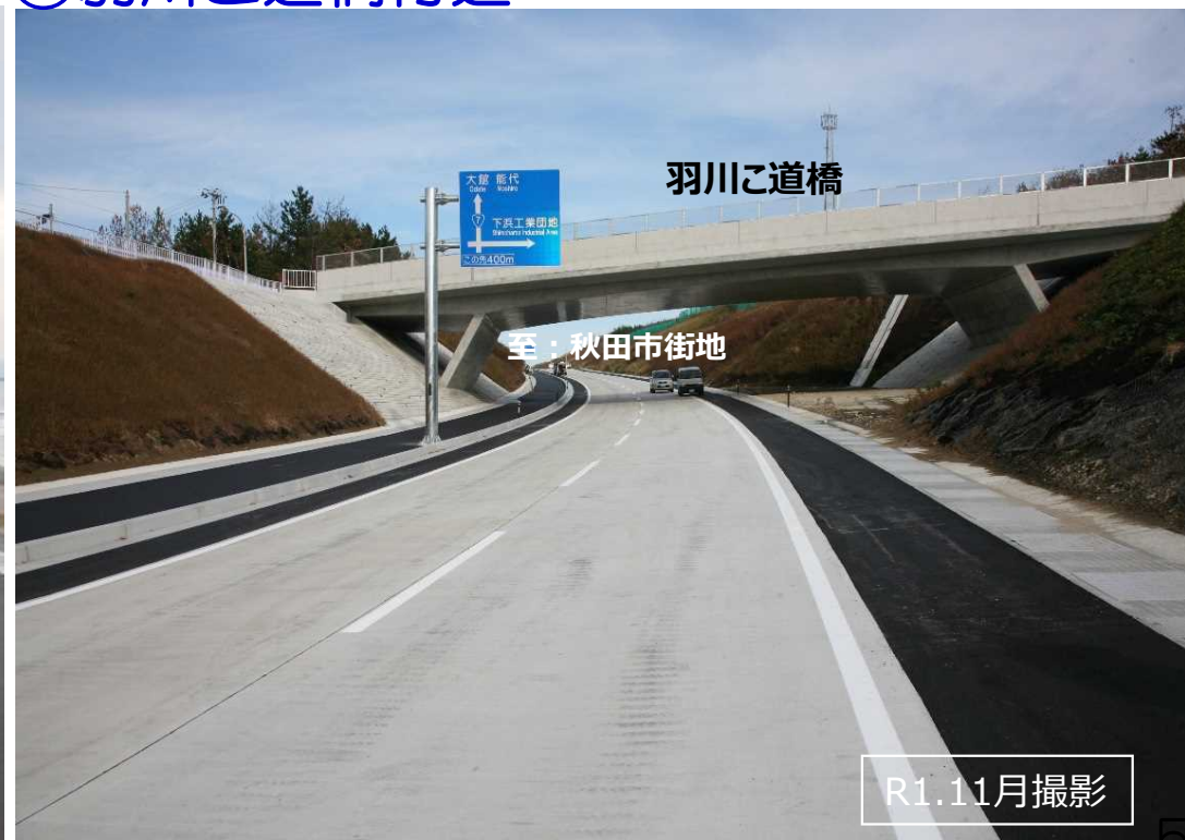
②羽川こ道橋付近
