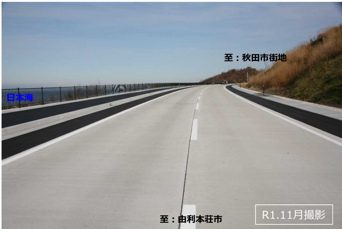
③中間部土工区間
