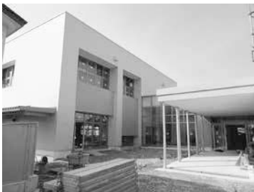
建設中の仁井田コミセン
