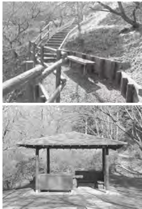
改修した園路(上)と東屋(下)
