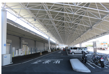
大屋根がかかった作業場 (姫路市中央卸売市場)
