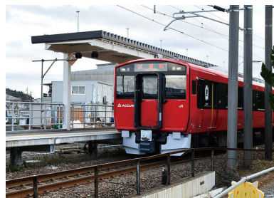
工事中の新駅のホームに試運転中の電車が停車していました
