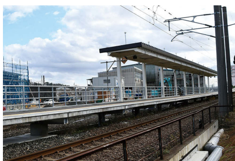
3月開設に向け、工事が進む「泉外旭川駅」 …8・9頁で特集
