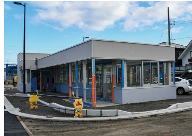
ロータリーに建設中のホームへつながる自由通路入口となる建物(泉側)
