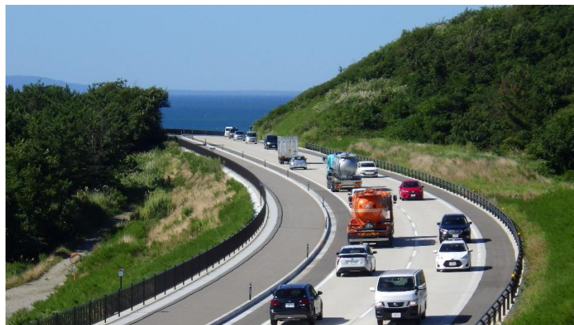
▲国道7号（下浜道路）の整備事例
