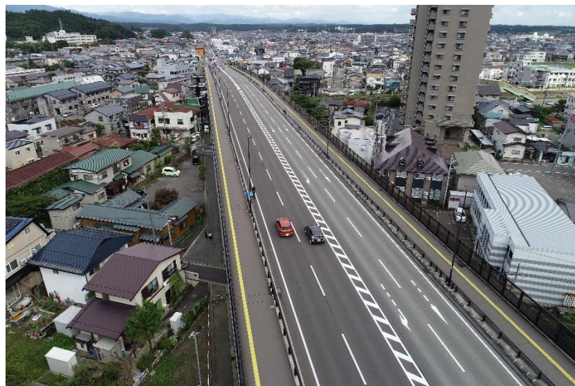
▲環状道路整備事例（都心環状道路：手形陸橋）
