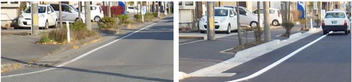
▲歩道の段差解消事例
