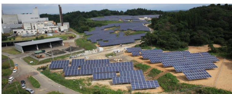
秋田市メガソーラー発電所
