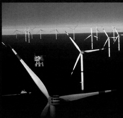
Northland PowerのNordsee1洋上風力発電所
