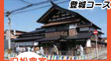
旧松倉家 住宅 *修復工事中
