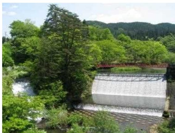
写真13 藤倉水源地水道施設
