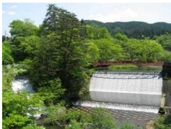
写真13 藤倉水源地水道施設
