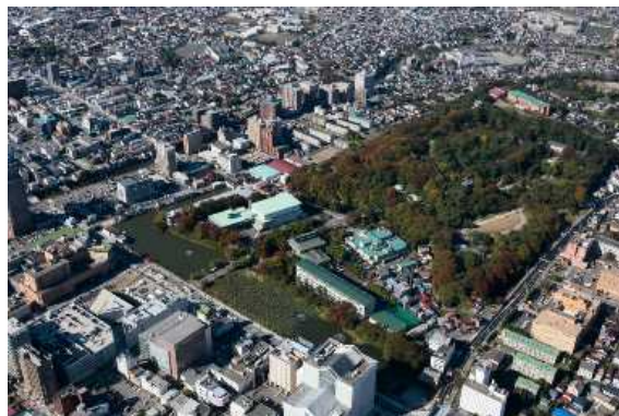
写真 55 久保田城跡の全景
