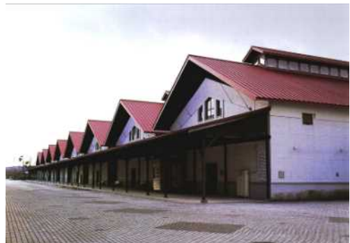
写真 30 秋田公立美術工芸短期大学実習棟一号棟ほか7棟 （国登録）
