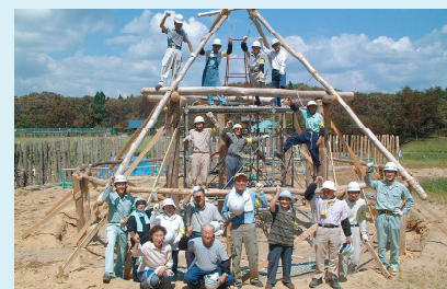
竪穴住居上棟記念写真(平成16年8月27日)
