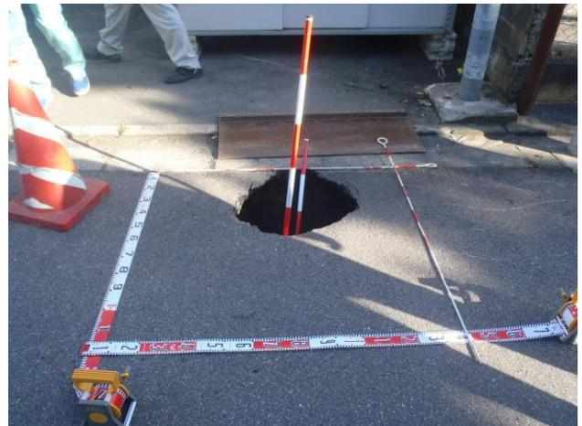
【老朽化した下水道管による道路陥没】
