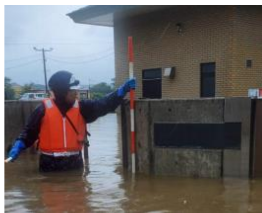
広面汚水中継ポンプ場
