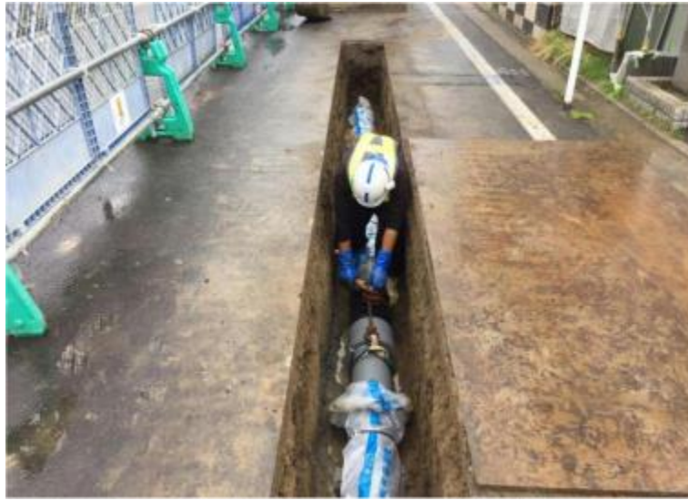
水道管の布設工事
