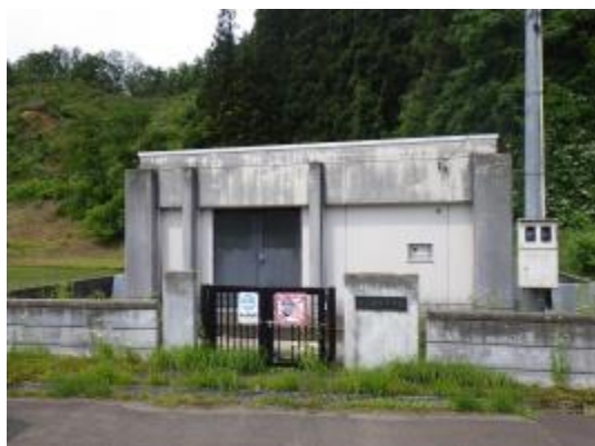
萱ヶ沢ポンプ場
