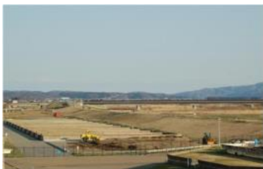
仁井田浄水場天日乾燥床
