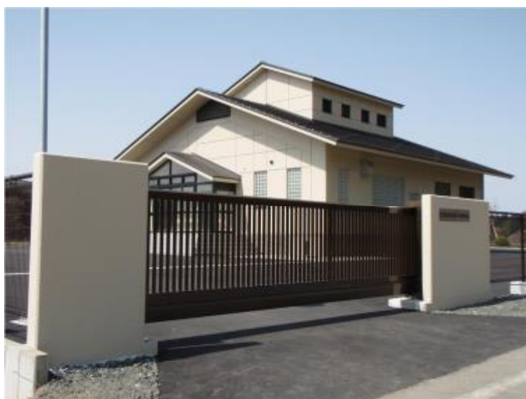
河辺岩見農業集落排水処理施設
