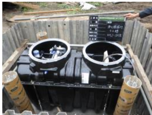
市設置浄化槽工事
