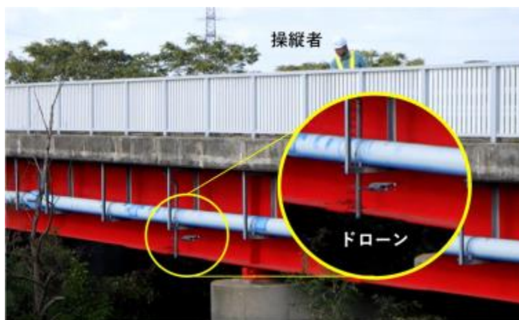
ドローンを活用した点検
