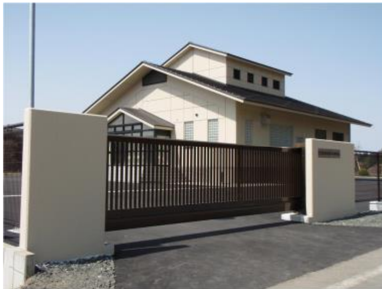
河辺岩見農業集落排水処理施設
