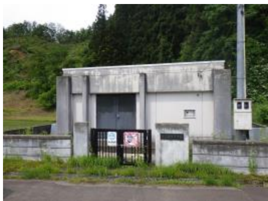
萱ヶ沢ポンプ場
