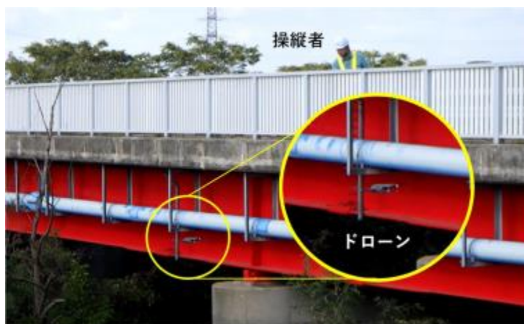
ドローンを活用した点検
