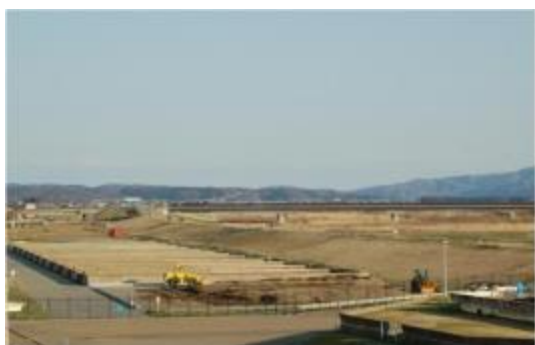
仁井田浄水場天日乾燥床
