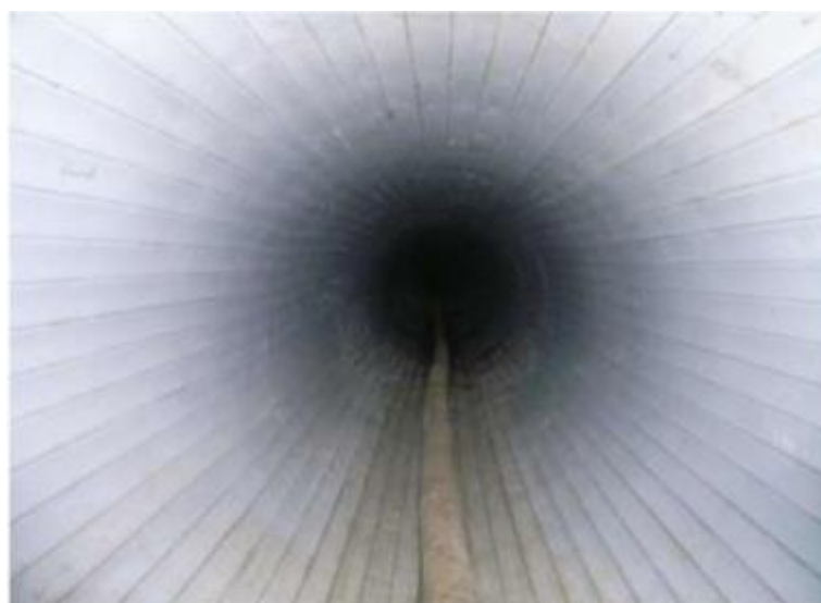
更生後の下水管の内面
