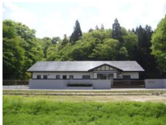
下北手中央農業集落排水処理施設
