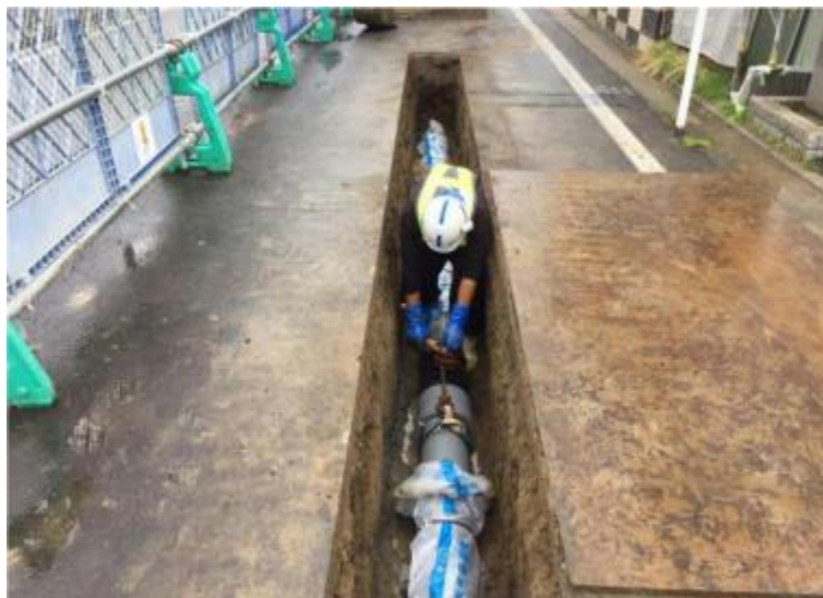
水道管の布設工事
