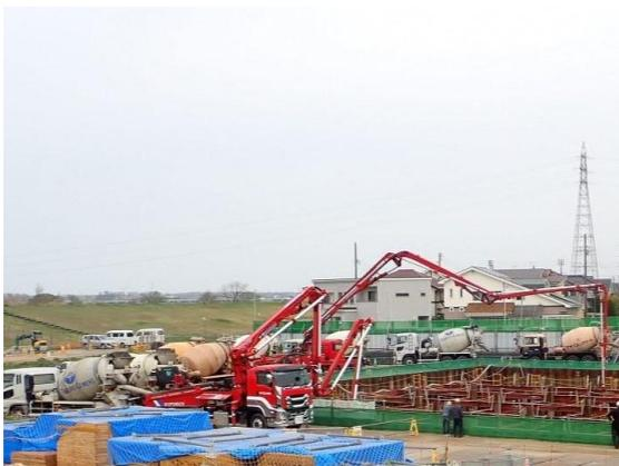
図5 ポンプ場(コンクリート打設状況)
