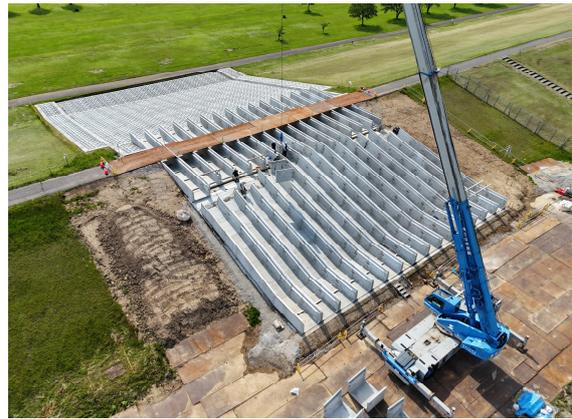
図4 護岸工・三面水路
