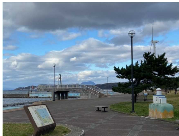
水素ボイラーが設置された道の駅みたら室蘭
