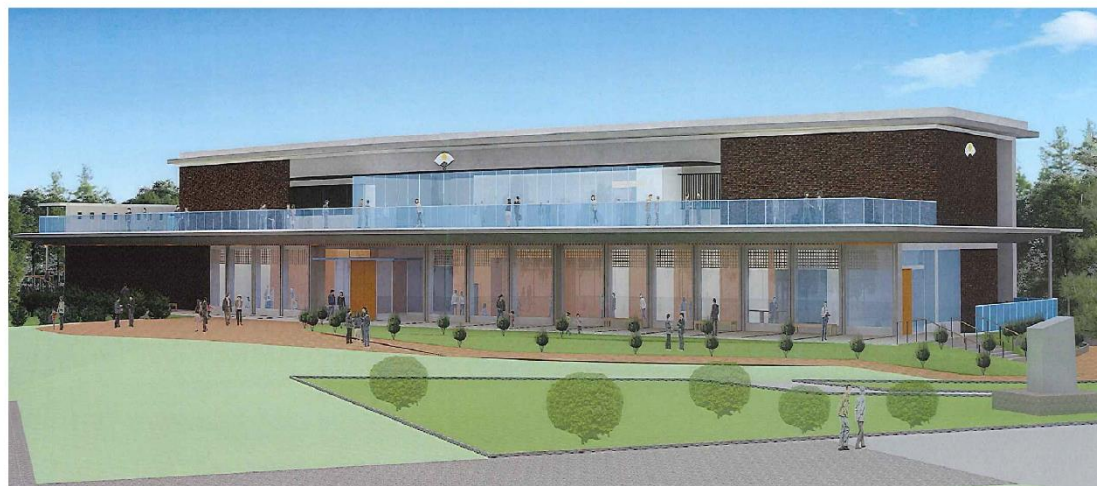
二の丸広場方向よりの外観イメージ
